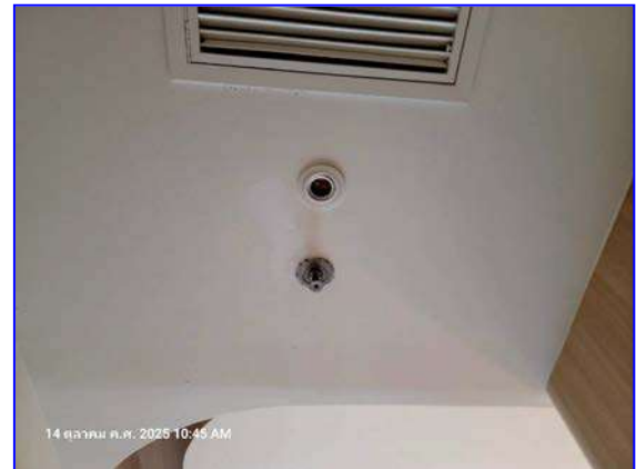
รูปที่ 2.18 อุปกรณ์ตรวจจับควัน และสปริงเกอร์ดับเพลิง
